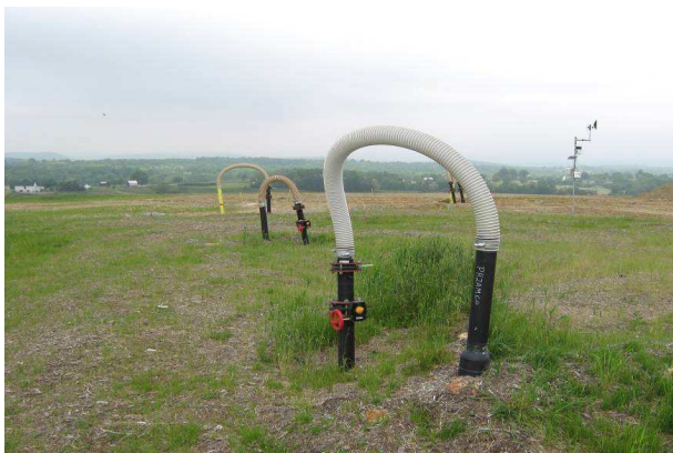
Рисунок 3 – Скважины, пробуренные в засыпанном котловане с отходами, для получения биогаза – метана
