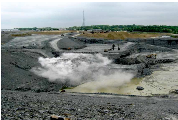
Рисунок 1 – Разрыхление взрывом скалистых пород при строительстве котлована для захоронения ТБО
