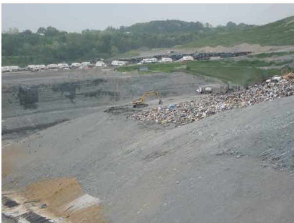
Рисунок 2 – Засыпка котлована отходами
