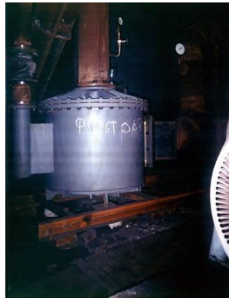
Гидродинамический неполнопоточный фильтр для очистки использованных промышленных вод
